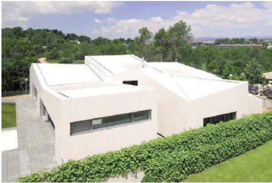
Biệt thự Casa Ubinana được ốp toàn bộ bằng gạch granite trắng
